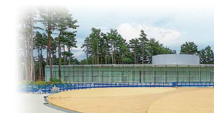
完成したウッドデッキ
